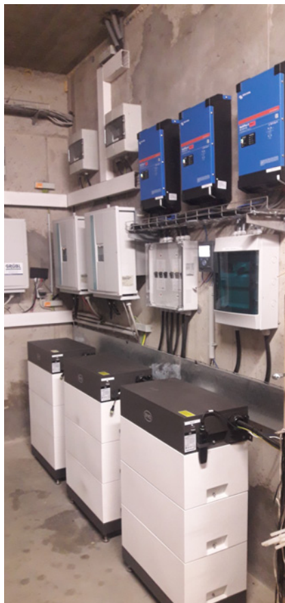
Drei Speicherboxen mit Batteriewechselrichter (blau)
