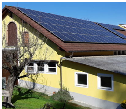
Südost ausgerichtete PV-Anlage
