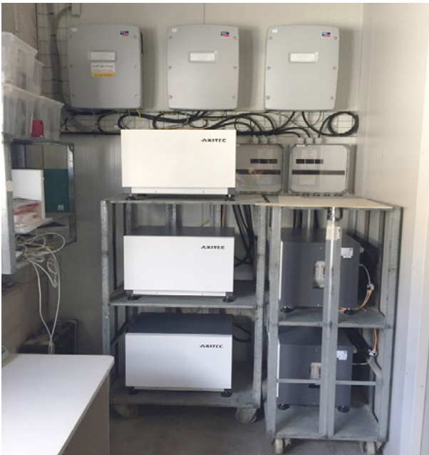
Speicher mit den Batteriewechselrichter
