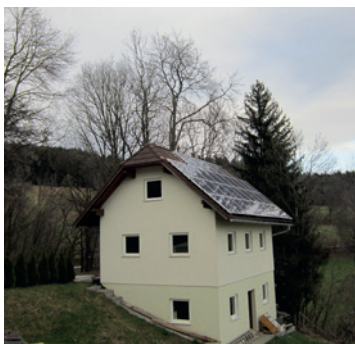
Speicheranlage und PV-Anlage
