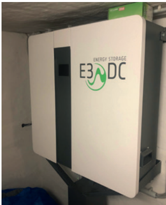
Hybridwechselrichter mit integriertem Speicher
